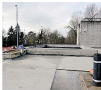
Il cantiere, sopra a sinistra, il nuovo massetto in stagionatura Ribolini
